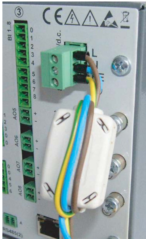
Рис. 4.4 Подключение фильтра источника питания
